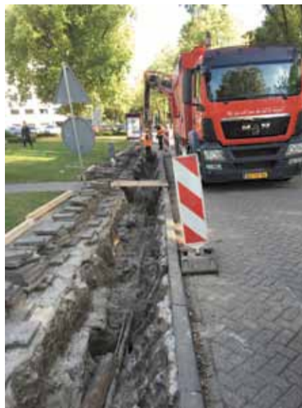
Ook hier is opslag van grond ongewenst. Grondzuigen biedt dan uitkomst. Met als bijkomend voordeel dat er geen graafschade ontstaat aan leidingen en kabels.
